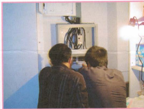
ให้ช่างไฟฟ้าดำเนินการเปลี่ยนแผงฟิวส์ เป็นตู้ควบคุมไฟฟ้า
