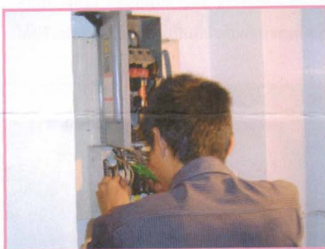
ตู้แผงฟิวส์เดิม มีปัญหาขั้วฟิวส์หลวม และฟิวส์ขาดบ่อย
